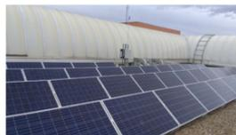
La instalación tiene una potencia nominal total de 10 kW y una potencia pico de 10,8 kWp.
